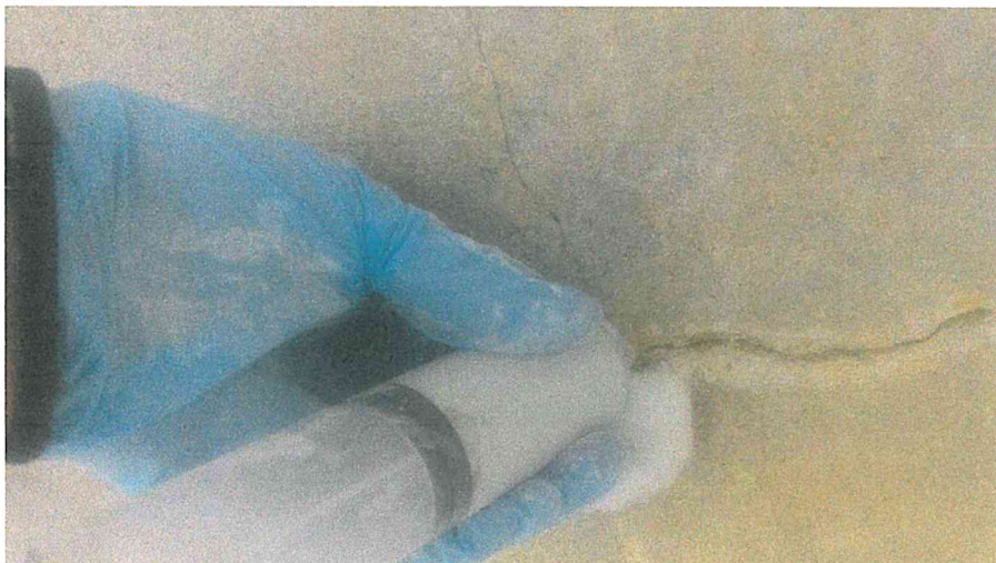
Foto 5 – Realizzazione iniezioni consolidanti
