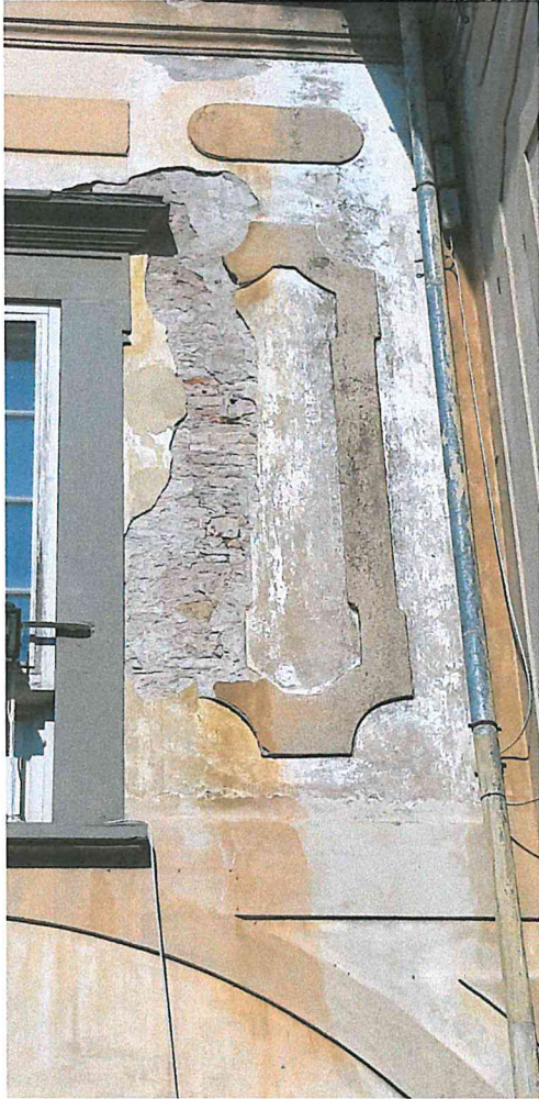
Zone delle facciate del cortile interno di Villa La Magia, in cui è rinvenibile la originaria coloritura bianca di fondo delle pareti
