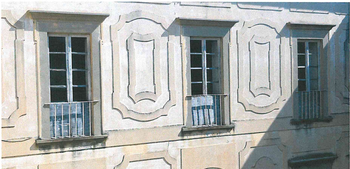
Segni di coloritura giallo scuro ad "imbrattare" le parti in pietra a riquadro delle portefinestre
