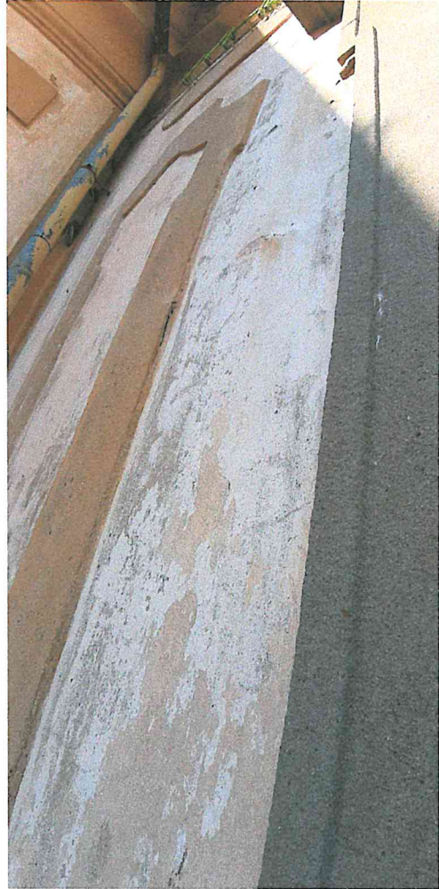
Zone delle facciate del cortile interno di Villa La Magia, in cui è rinvenibile la originaria coloritura bianca di fondo delle pareti
