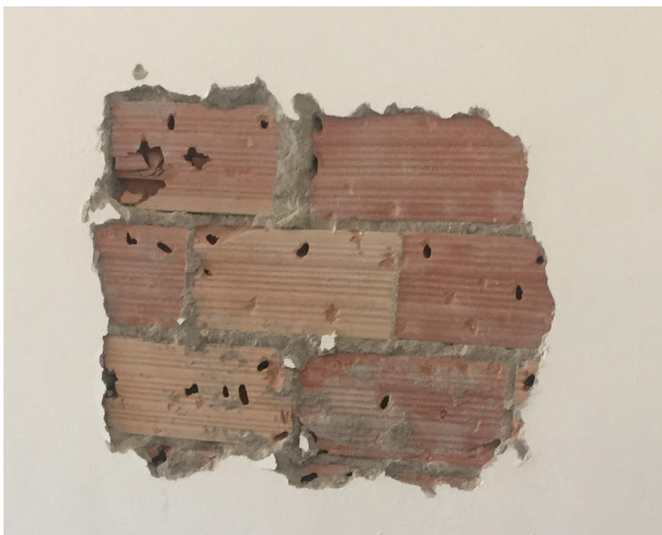
Saggio 13: rimozione intonaco
