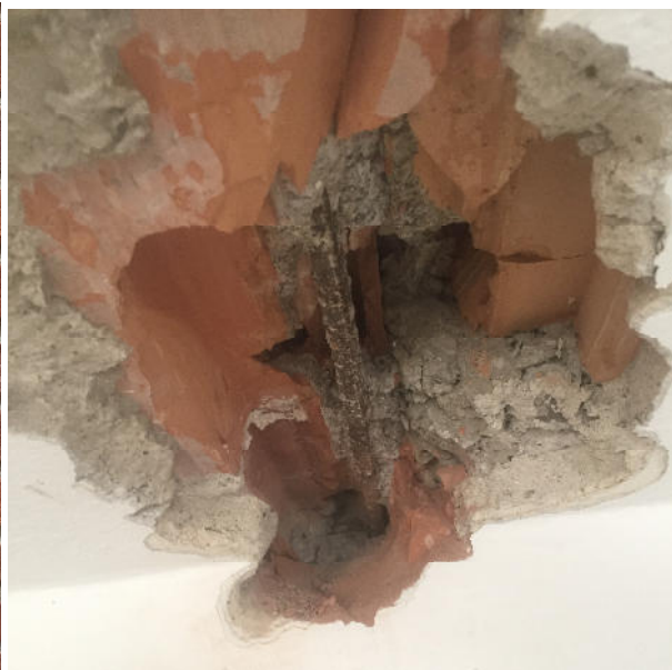
Saggio 3: ammorsamento barre del solaio nelle murature d'ambito
