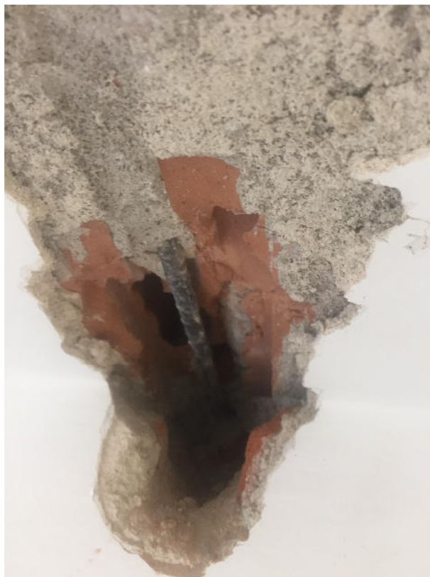
Saggio 5: ammorsamento barre del solaio nelle murature d'ambito
