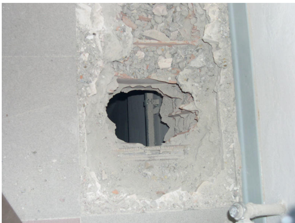
Saggio sulle armature e sulla soletta del solaio di piano primo
