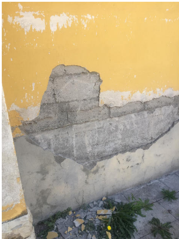
Saggio 7-8: rimozione intonaco su muratura di tamponamento in blocchi cls
