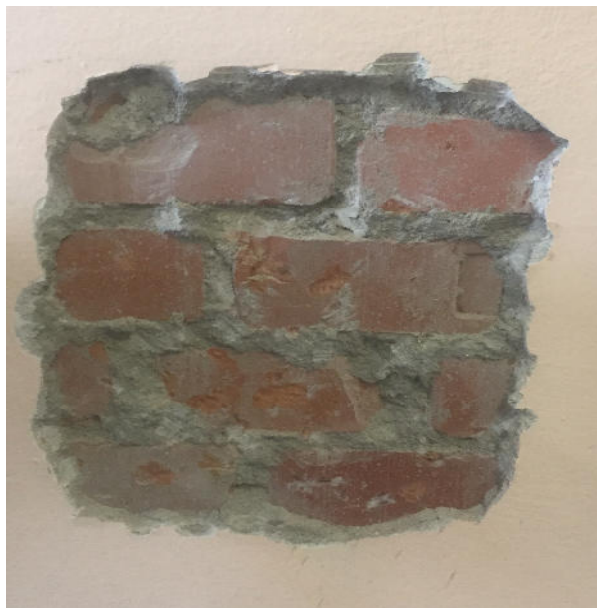
Saggio 9 rimozione intonaco
