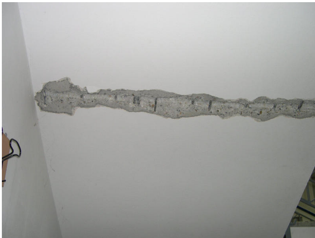
Saggio su soletta rampa scale
