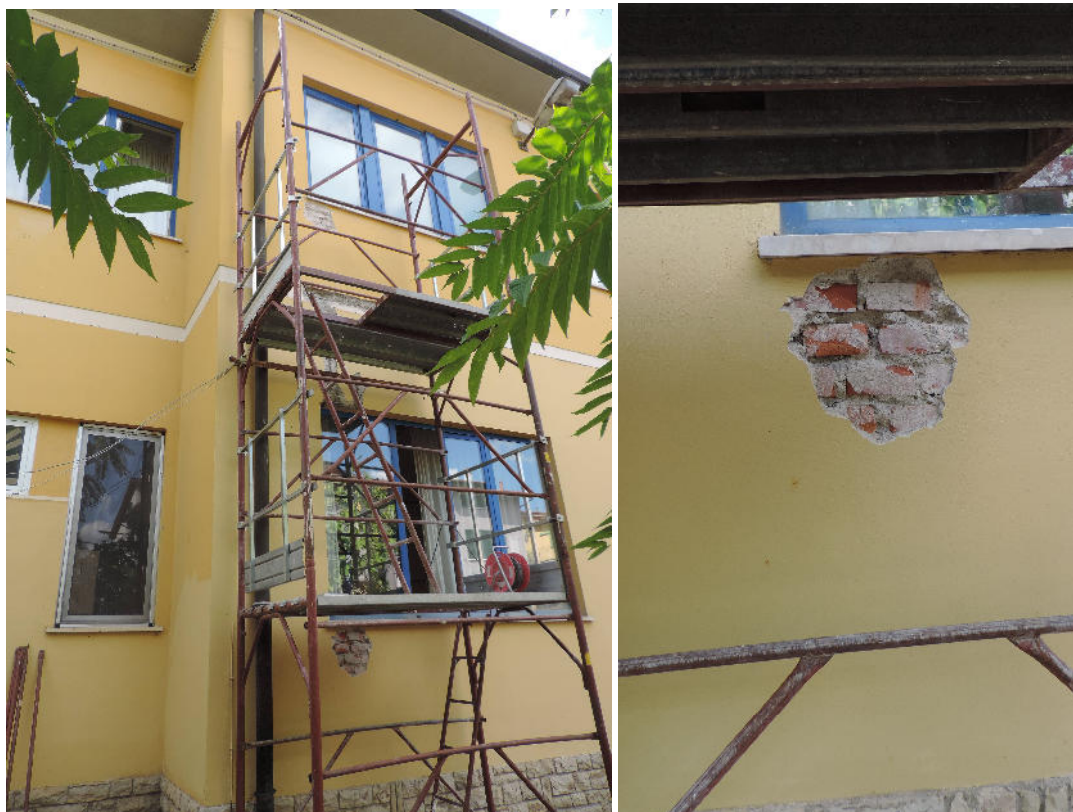
Saggio 12 : saggio sui cordoli delle porzioni in muratura – particolare sottofinestra di piano terra in mattoni pieni senza cordoli in c.a.
