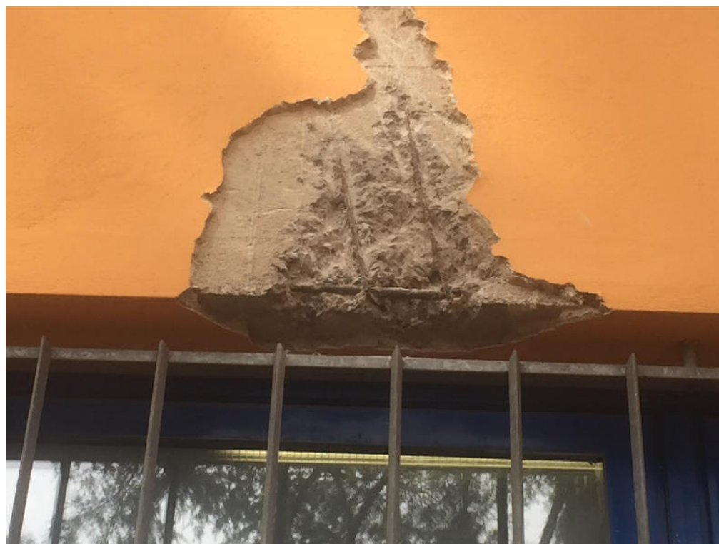
Saggio 4 armature architrave
