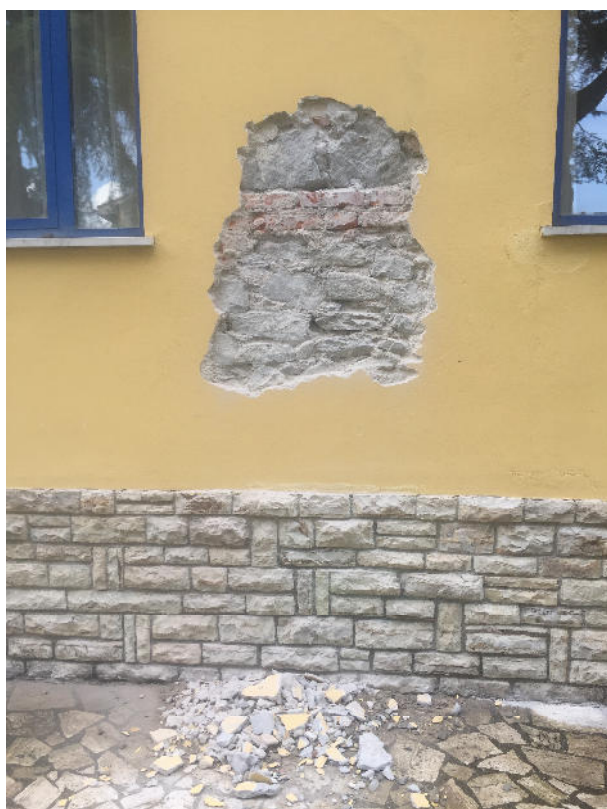
Saggio 4: rimozione intonaco su muratura in pietrame listata
