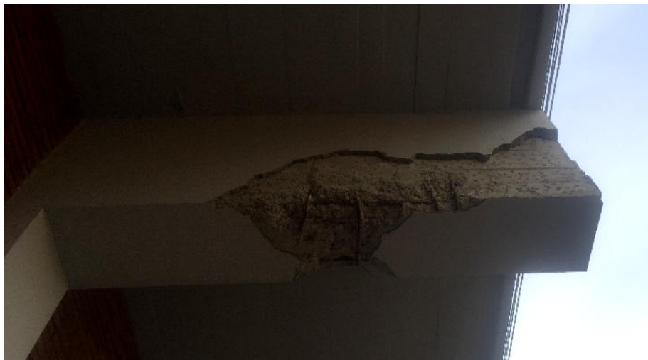
Saggio 7: rilievo armature mensola in c.a.
