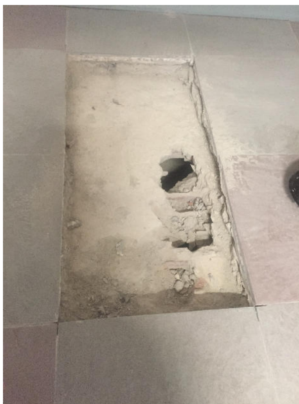
Saggio 11 : soletta solaio piano 1
