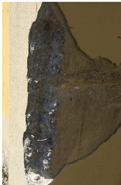
Saggio 2 armature di un pilastro di piano terra con prelievo spezzoni per prove di laboratorio
