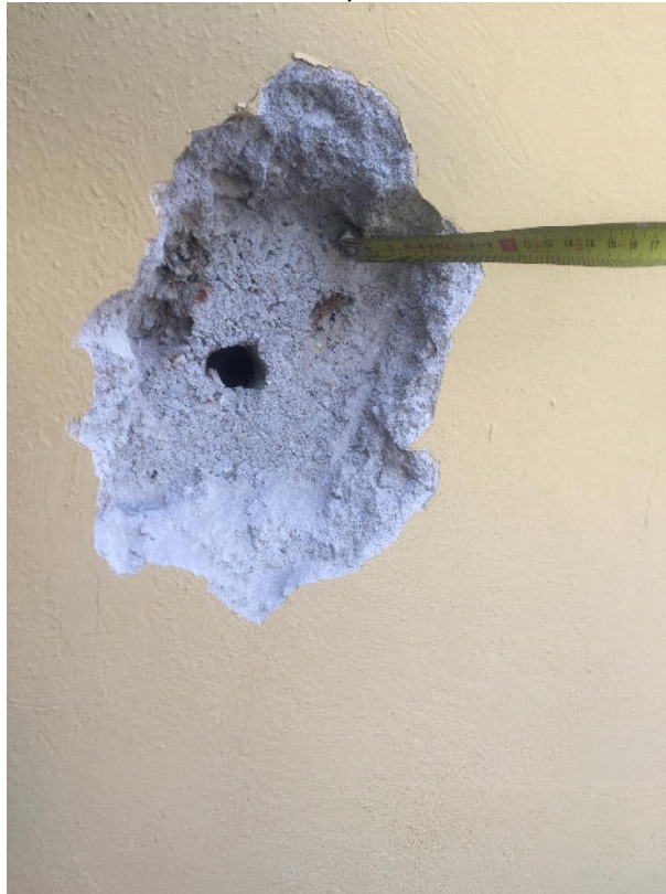
Saggio 7-8: rimozione intonaco su muratura di tamponamento in blocchi cls
