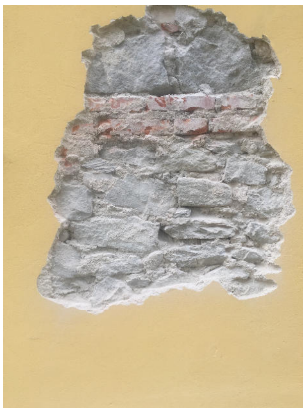
Saggio 4: rimozione intonaco su muratura in pietrame listata
