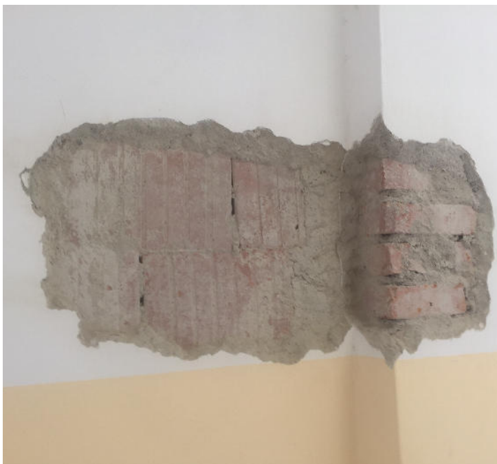
Saggio 9 armature di un pilastro di piano primo con prelievo spezzoni per prove di laboratorio
