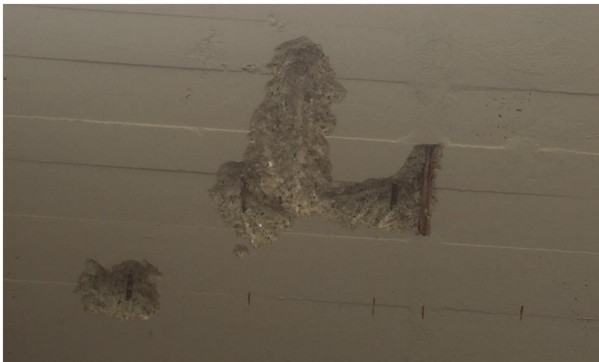
Saggio 8: rilievo armature soletta in c.a.
