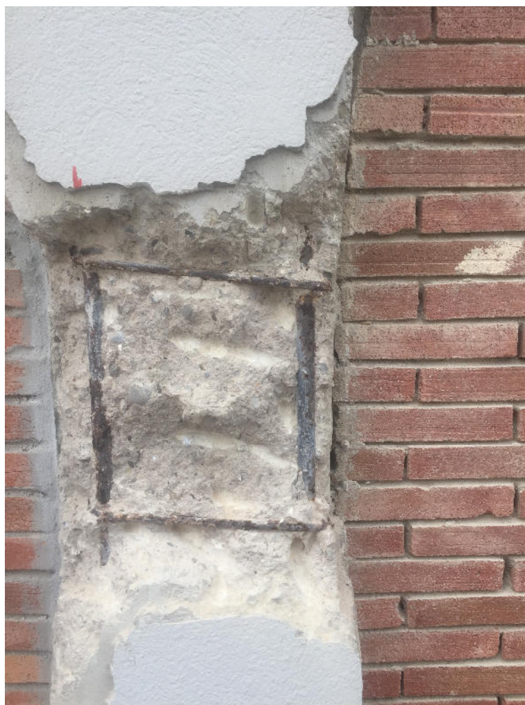
Saggio 6: rilievo armature pilastro
