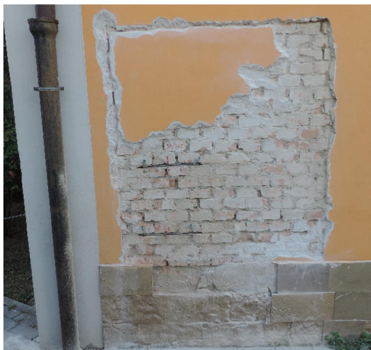
Saggio 11: rimozione intonaco
