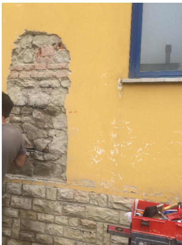
Saggio 6: rimozione intonaco muratura in pietrame listata
