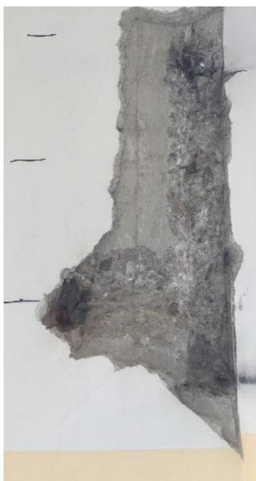
Saggio 9 armature di un pilastro di piano primo con prelievo spezzoni per prove di laboratorio
