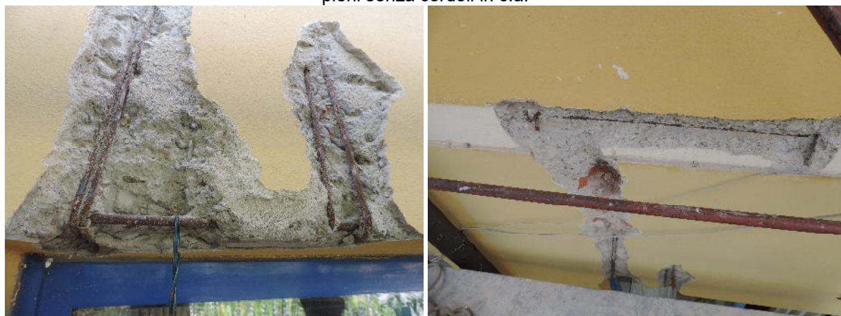
Saggio 12 - particolare architrave finestre piano terra e cordolo di piano primo
